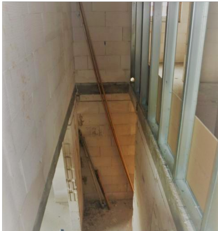
Treppe EG zum DG
