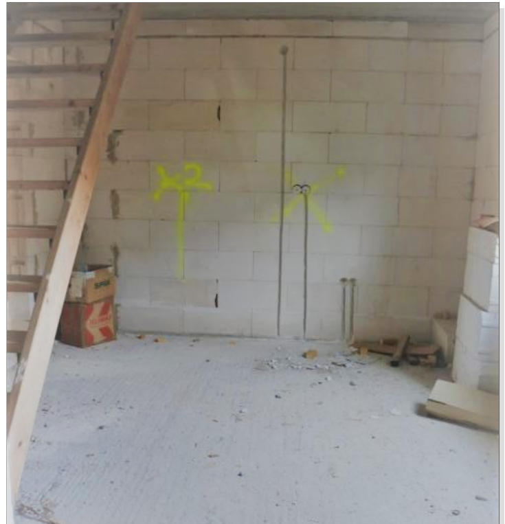
Treppe zum Spitzboden
