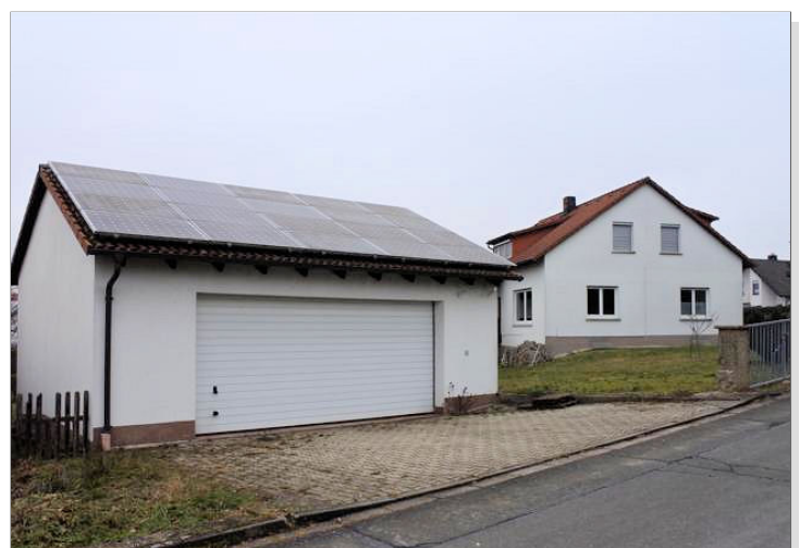
Haus mit Doppelgarage Photovoltaikanlage
